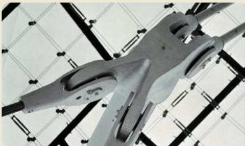
Knoten einer Hängedachkonstruktion im Münchener Olympiastadion
